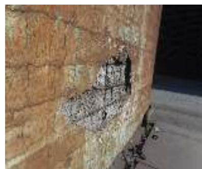
شکل ۴ - نمونه های از خوردگی‌های بتن
