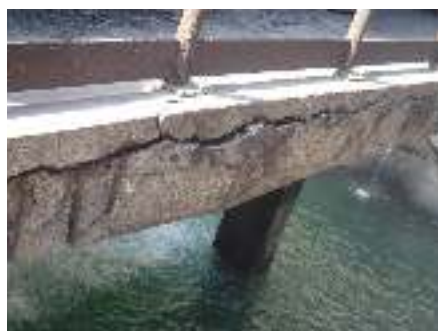
شکل ۴ - نمونه های از خوردگی‌های بتن
