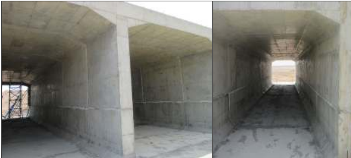
شکل ۹- نمایی از آبروهای اجرا شده در پروژه راه آهن سریع السیر تهران- قم- اصفهان پس از اصلاح طرح مخلوط بتن و رعایت اصول صحیح ویبره زنی و آموزش بیمانکاران
