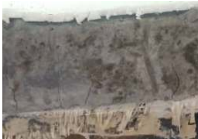
شکل ۸- ایجاد ترک خمشی در دال بتنی تقویت شده با ۲ لایه ورق GFRP
