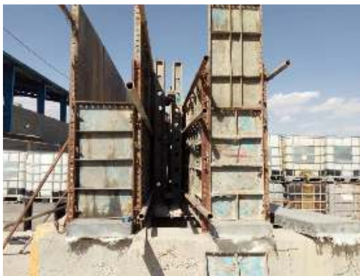
شکل ۳- قالب بندی دال با ۲ و ۳ لایه ورق GFRP
