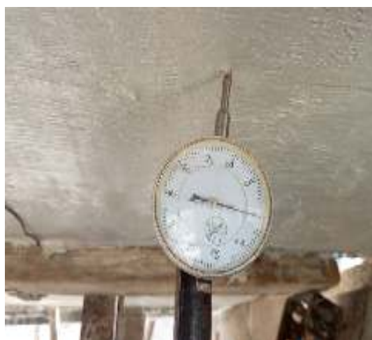
شکل ۴- نصب دایال گیج وسط دال
