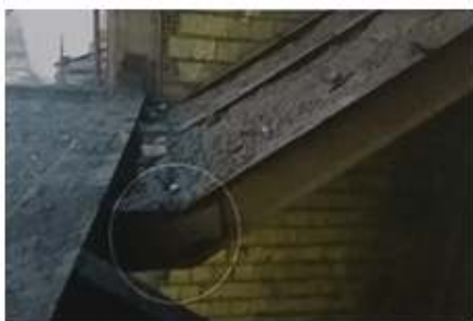
شکل (۲۳) - استفاده از ورق در محل اتصال
