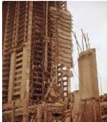
شکل ۲- ساختمان تجاری اسکای لاین پلازا [۲]
